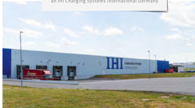
Langfristig vermietete Produktionsstätte an IHI Charging Systems International Germany
