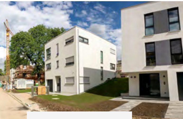
Platz für 43 Ein- und Zweifamilienhäuser sowie Reihenhäuser bietet das Weimarer Wohnbauquartier »Schießhaus«
